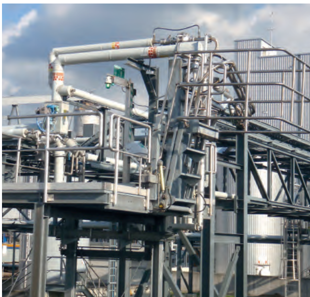
Tanknotdusche in Leitung eingeschliffen / Freier Auslauf DIN 1717
